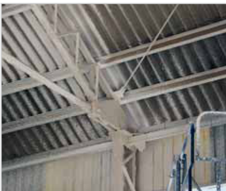
Aplicación de mortero. R 180
