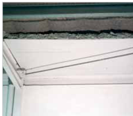
Cortafuegos de panel con lana de roca. EI 120
