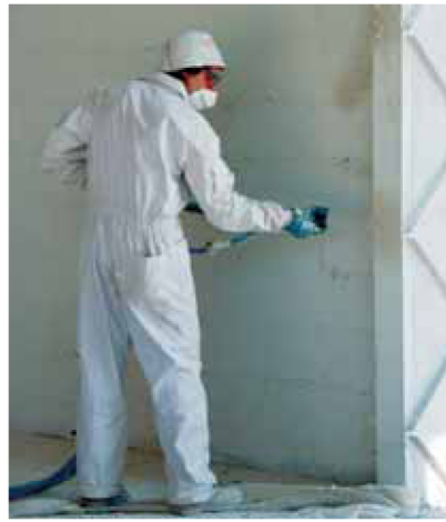
Aplicación de mortero por proyección o utilizando las técnicas habituales de albañilería
